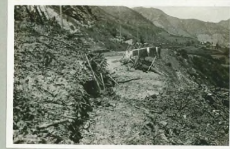
Brisighella - frana in località Pendici
