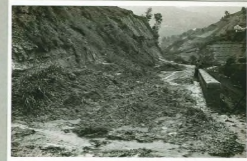
Modigliana - frana sulla strada Monte Trebbio
