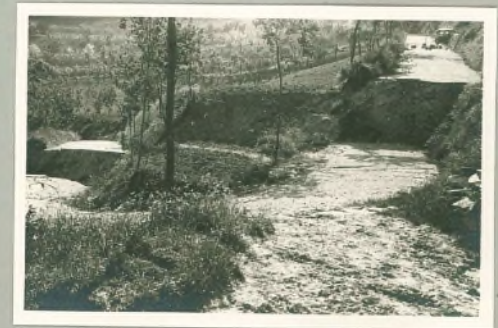
Marradi - frana sulla strada Marradi-Lutirano
