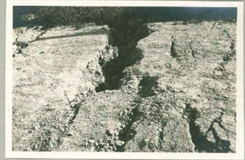
Marradi - frana sulla strada Marradi-Lutirano
